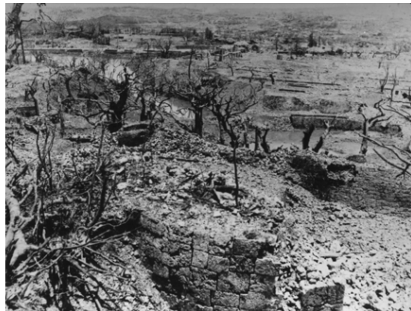
図2 ● 沖縄戦で破壊された首里城と首里の町並み 手前の石垣は首里城跡の城壁、右が円鑑池(えんかんち)で左が龍潭(りゅうたん)。龍潭の北に接していた琉球国王世子邸中城御殿(なかぐすくうどうん)の建物群も焼け落ち、みるかげもなく破壊しつくされた首里の町並み。
