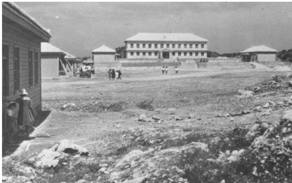
図3 ● 開学当初の琉球大学本館ビルと構内 現在の首里城奉神門前の下の御庭(うなー)方面より撮影された琉球大学2階建ての本館。首里城正殿は本館前の駐車場地下で検出された。
